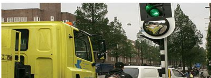
FIGURE 4 : MIROIR POUR ANGLES MORTS INTÉGRÉ À UN FEU DE CIRCULATION
